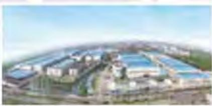
Sito di Ningbo
